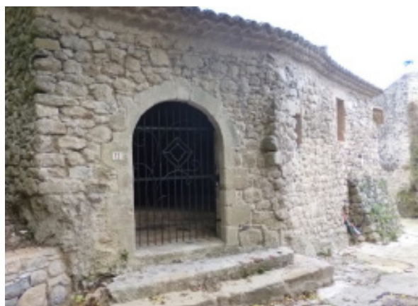
Le four à pain, vu extérieure - Source : Recensement du patrimoine du Grand Site
