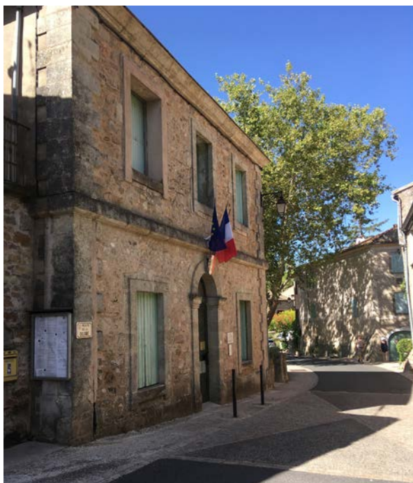
La Mairie, bâtiment structurant de la traversée
