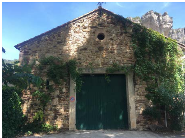
La façade d'un bâtiment agricole
