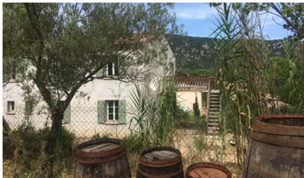
Une construction récente englobant plusieurs logements dans un même bâtiment
