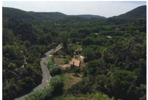
Vue plongeante sur la combe dans laquelle sillonne la route
