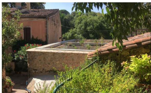
La toiture de la Salle des Rencontres
