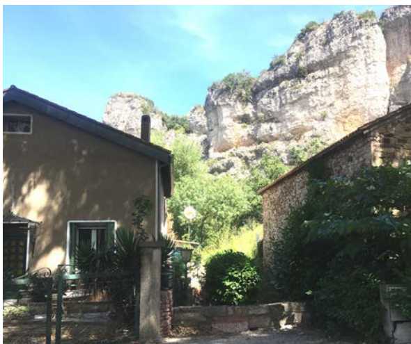
Façades typiques avec les ouvertures d'origine conservées
