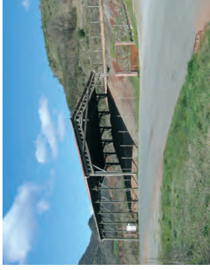
La halle de la Lieude, sa charpente en treillis de bois et sa toiture parallèle à la voie et aux pentes du relief.
