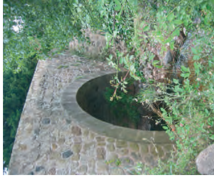
Pont sur le ruisseau Lignous, au niveau de Malavielle
