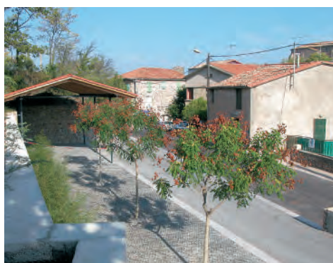
Réaménagement de la traversée de Liausson (arch : atelier Sites)
