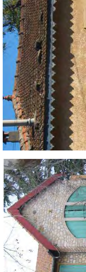
Le débord de toitures avec planches de rives en bois, en zinc et en terre cuite (de gauche à droite)
