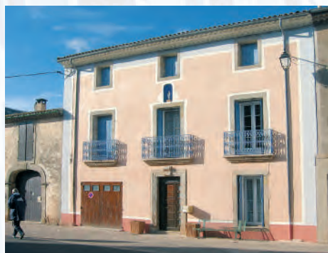
Réhabilitation à Salasc
