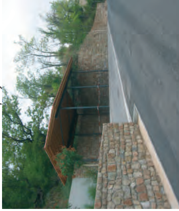
A Liausson, la sobriété de l'ensemble du traitement, l'intérêt de la pierre locale extraite des champs environnants pour la construction du mur de soutènement, contribuent à la réussite du projet. Maître d'oeuvre : cabinet Sites.
