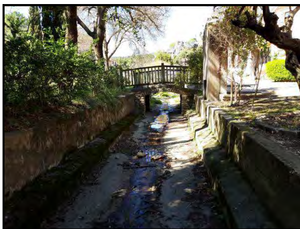
Vues du ruisseau des Rats après la confluence avec le ruisseau des Ebouls
