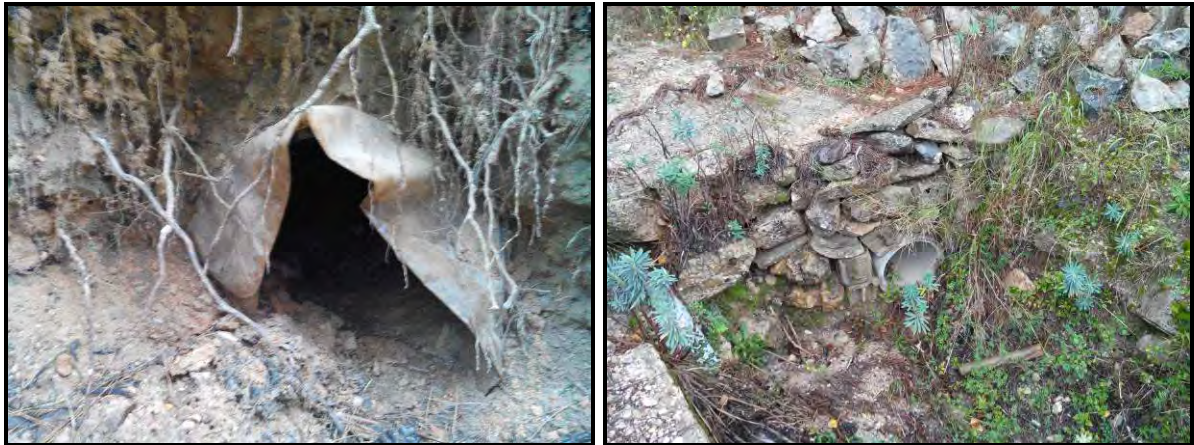
Vues Amont et Aval de la buse Ø400 (OH8)
