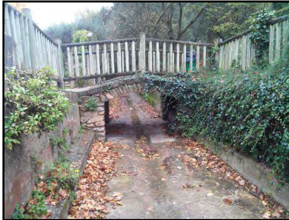
Vue du bâti en pierre maçonné (OH3)
