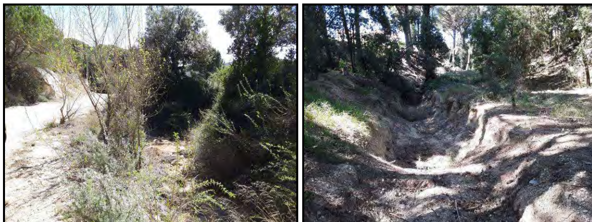
Vues du Ruisseau des Ebouls sur sa partie Amont
