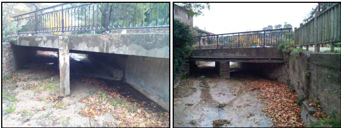
Vue des 2 bâtis maçonnés sous la RD8
